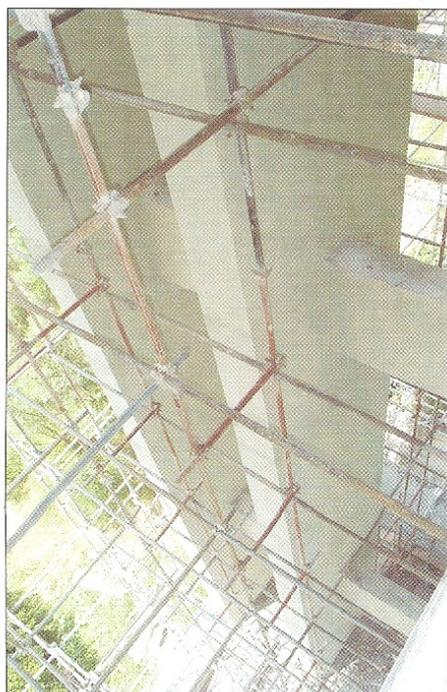
cessario all'esecuzione del ponteggio (40.000 giunti e 60.000 m di tubo) sono stati calati dall'autostrada con riduzione provvisoria di carreggiata, poiché il fondovalle è inaccessibile per mancanza di strade e per l'impossibilità di creare tracciati provvisori all'interno dell'abitato di Celle Ligure.
